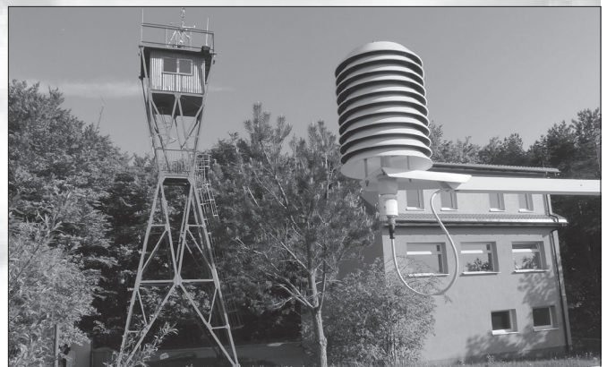
Widok na budynek SMUS i wieżę z zainstalowaną aparaturą pomiarową.
