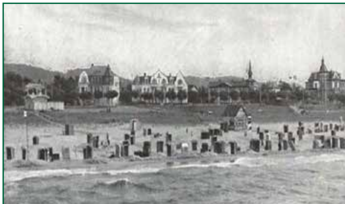
! Panorama Międzyzdrojów ok. 1913 r. Po prawej hotel „Bałtyk” i zespół zabudowy Domu Zdrojowego
