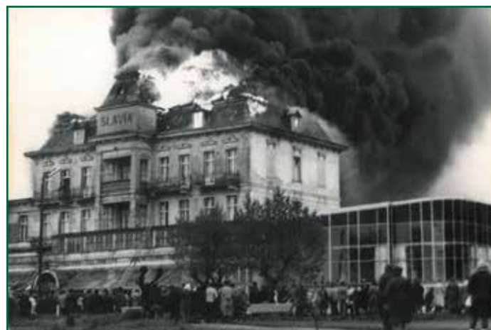
I Dom Wczasowy „Slavia” w trakcie pożaru
